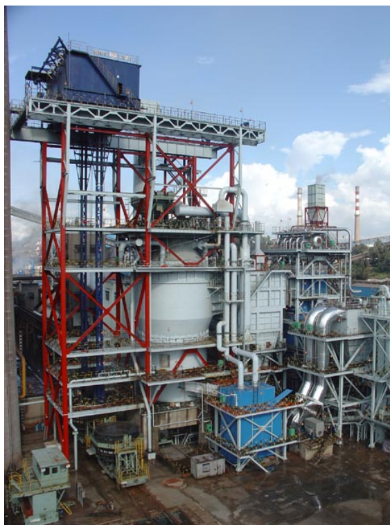
图 3-54 干法熄焦装置
