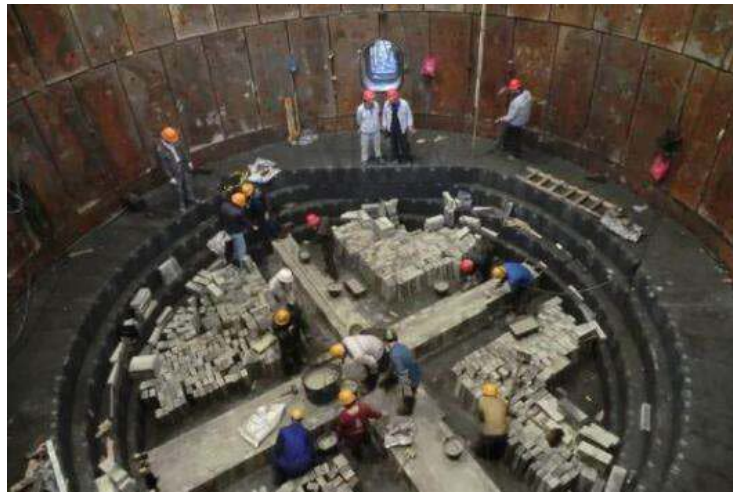
图 8.5 砌筑高炉底
